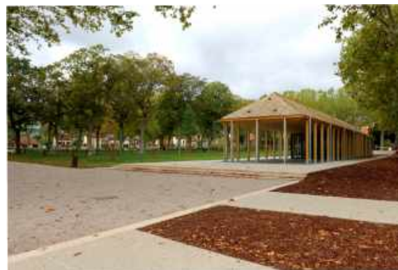
Gannat, Le champ de foire, en 2020, fin des travaux de la place, vue sur la nouvelle halle, base contemporaine de la banque d'images
